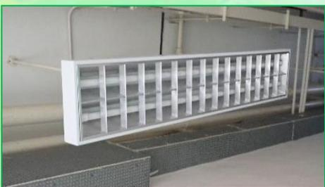
「運動傳感器無閃頻 LED 光管」可保護視力，每支獨立設定不同探測距離（3 米至 8 米）、觸發後的全亮時間（5 秒至 60 分鐘）及無人時的備用光度（0%至 90%），會自動關掉或變暗，節省能源！
