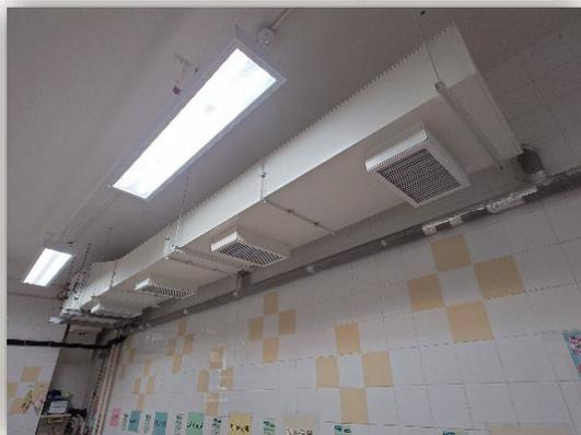
本園兒童洗手間採用「線性調速調壓直流風櫃」，按預設的目標，控制電動機的速度，減少耗電，達至節能效果，優化兒童洗手間的抽氣系統。
